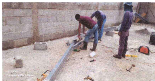
Foto 6: iniciando de soldar las tijeras cargalaminas.
