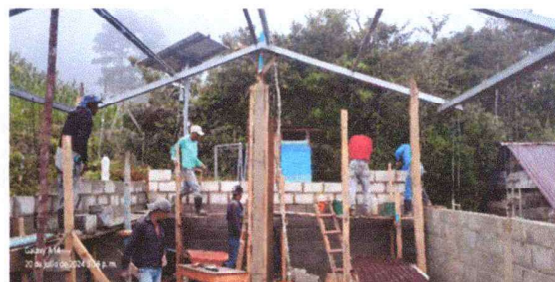
Foto 4: levantado de bloks.
