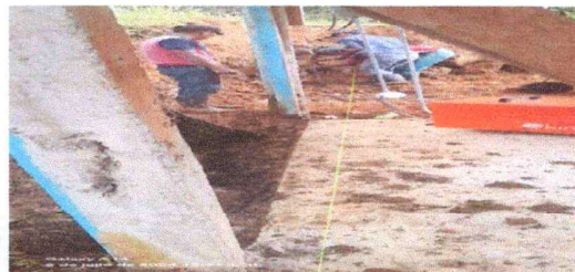
Foto 2: Trazo de nivelacion de la escuela.
