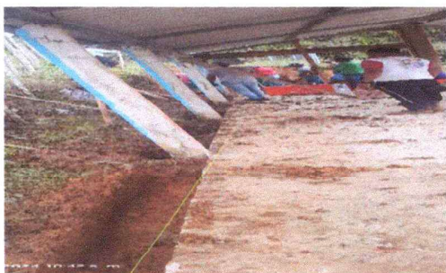
Foto 3: Escavacion del lugar de cimiento de la escuela
